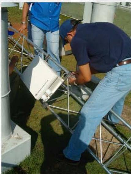
Montagem da caixa do datalogger.
