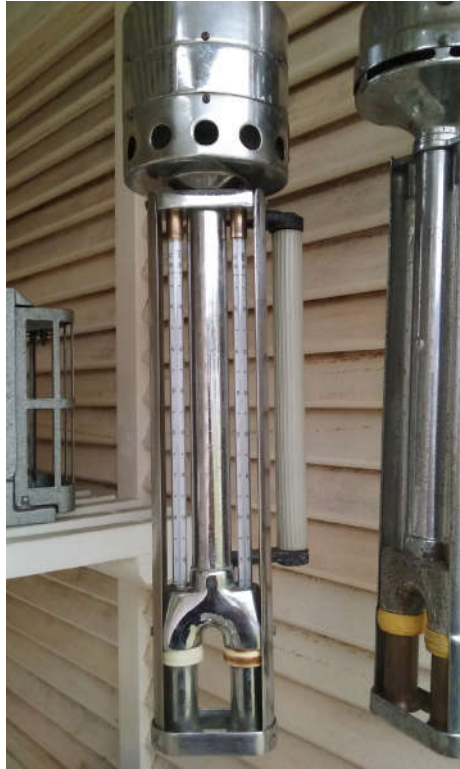
Figura 6 - Psicrômetro limpo, montado e instalado. Ao lado direito, o equipamento reserva que funciona a corda e é utilizado quando há falhas na energia elétrica.
