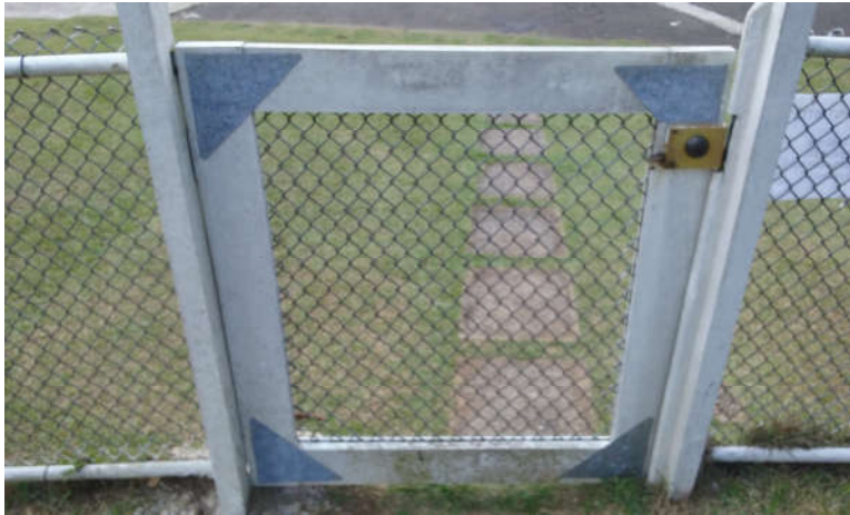
Figura 8 - Portão do cercado meteorológico após a manutenção.
