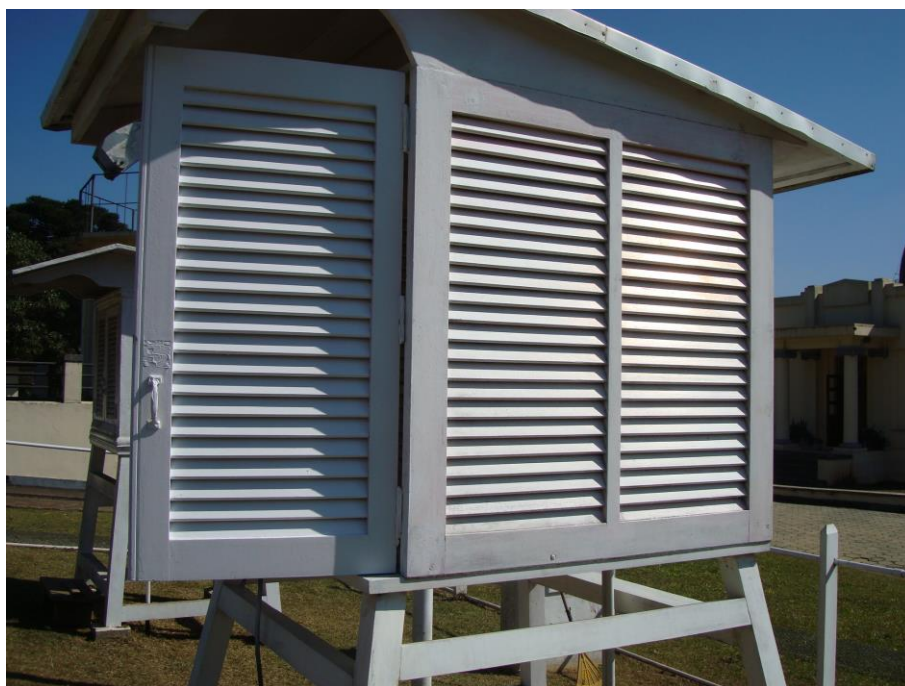
Figura 1 - Abrigo meteorológico em processo de pintura, no dia 07 de julho de 2017.
